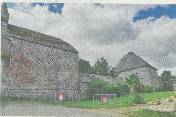
La Maison des associations d'Érezée devrait prendre place dans le corps de logis de la ferme château de Soy (à droite).
