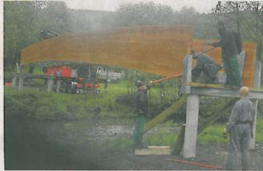
La passerelle en passe d'être installée.
