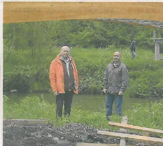
Denis Trequatrini et Marcel Schutz ont supervisé les travaux.
