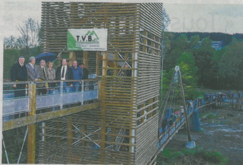
Beaucoup de monde vendredi pour emprunter la nouvelle passerelle enjambant la Sûre qui est opérationnelle depuis ce week-end.
