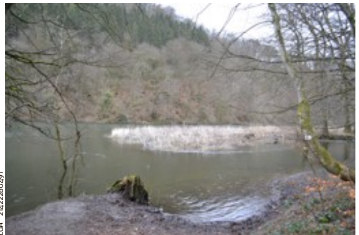
Le site du moulin de l'Épine où la passerelle enjambrera la Semois pour relier les promenades de Bouillon à Corbion.
