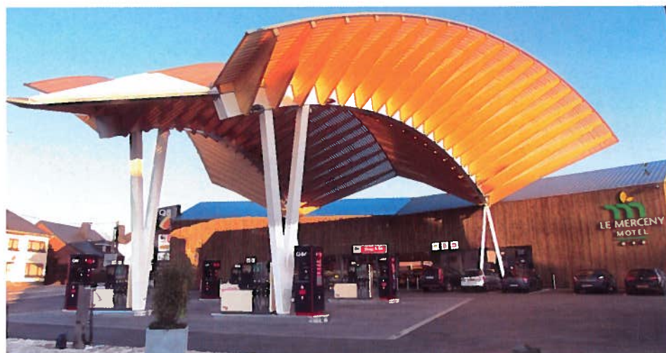
Les 800 m 2 de la coupole au-dessus d'une station essence de Bastogne, l'une des fiertés de l'entreprise.
